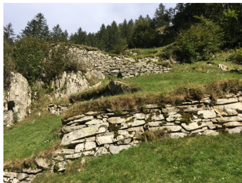
Abbildung 5: Steinmauern zur Terrassierung eines Hanges.
